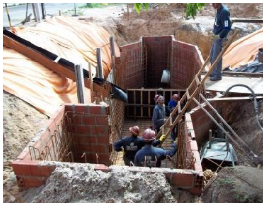
Figura 2: Construção da caixa separadora Fonte: registro do próprio autor
