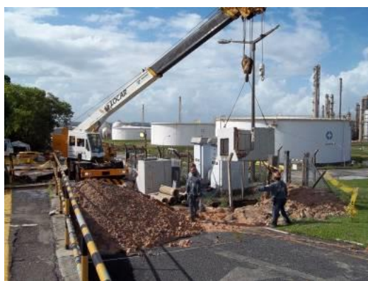
Figura 1: Montagem das caixas de passagem pré-moldadas Fonte: registro do próprio autor
